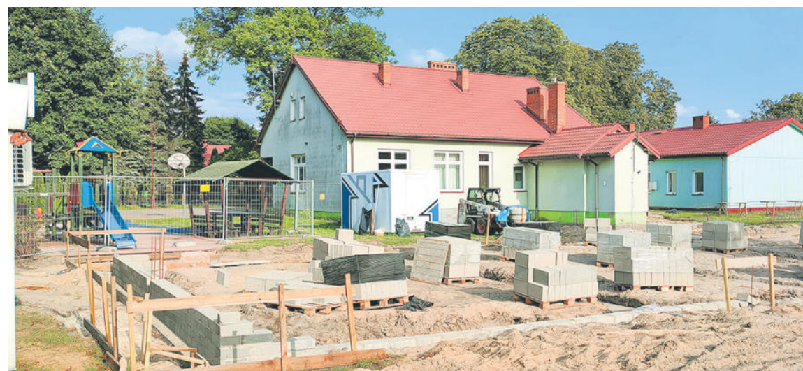
Teren przy szkole w Nowej Wsi zmienił się w plac budowy.
