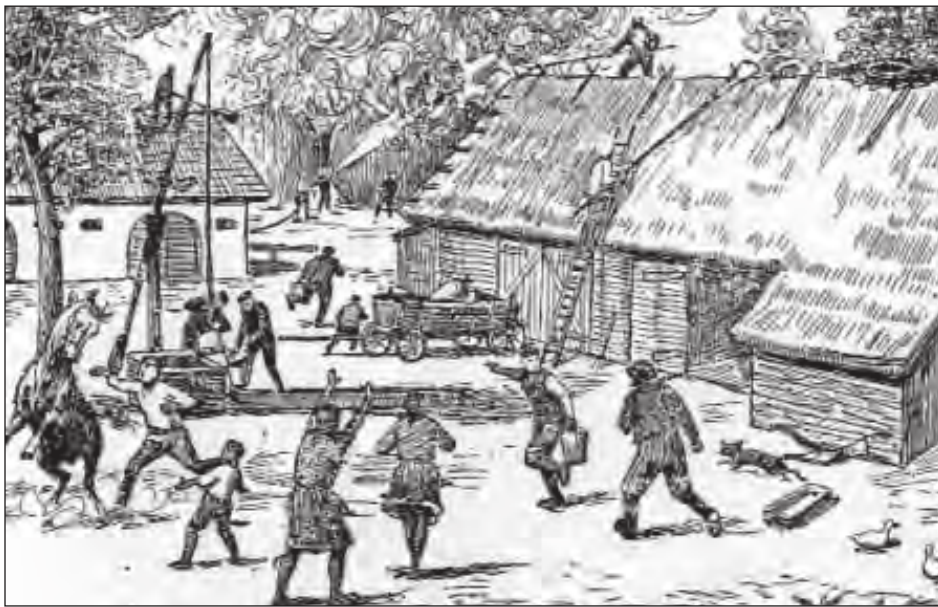
■ Pożar wiejskich zabudowań - tak mógł wyglądać pożar w Żelechowie w 1880 roku (Komenda Główna Państwowej Straży Pożarnej; www.gov.pl)
