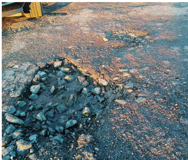
Droga 510 na odcinku Lełkowo - Głębock, pow. braniewski
