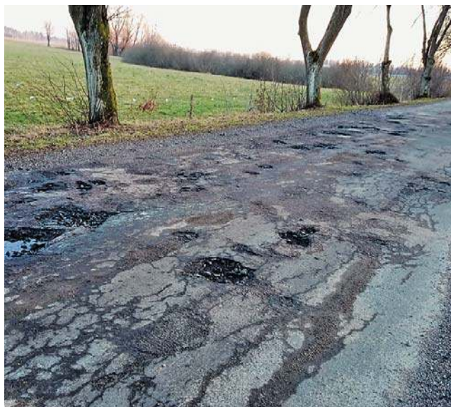
Droga 510 na odcinku Lełkowo - Głębock, pow. braniewski
