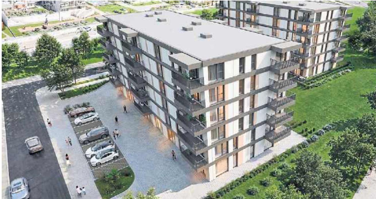
W planach jest budowa dwóch bloków, lokali usługowych i garażu podziemnego
