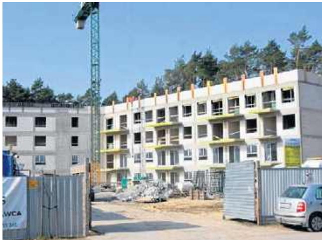
Tak prezentuje się stan budowy bloku u zbiegu Alei Solidarności i ulicy Sikorskiego w Kozienicach.
