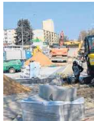
Przyspieszyły prace przy budowie mostu.
