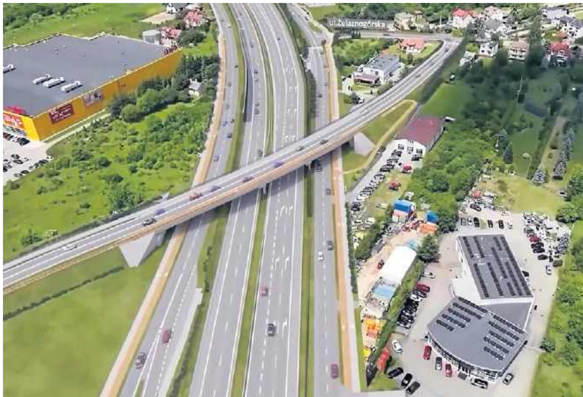
Budowa rozpocznie się na odcinku ulicy Łódzkiej między obwodnicą, a dwupasmową część ulicy Łódzkiej
