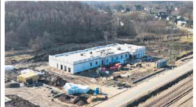
Postępy na budowie żłobka w Kosowie
