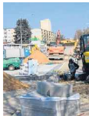
Przyspieszyły prace przy budowie mostu.
