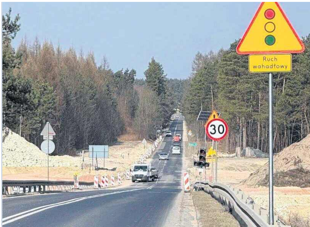
Utrudnienia na ulicy Młynarskiej we Włoszczowie. Ruch odbywa się wahadłowo i jest sterowany sygnalizacją świetlną.
