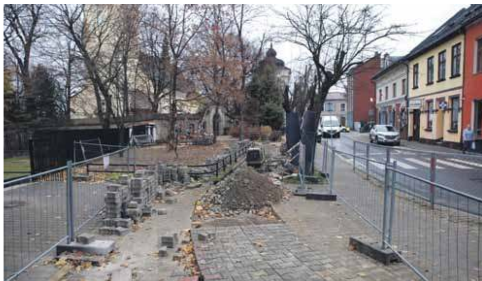
Wykopy w centrum miasta związane są z kolejnymi przyłączami do sieci MPEC.
