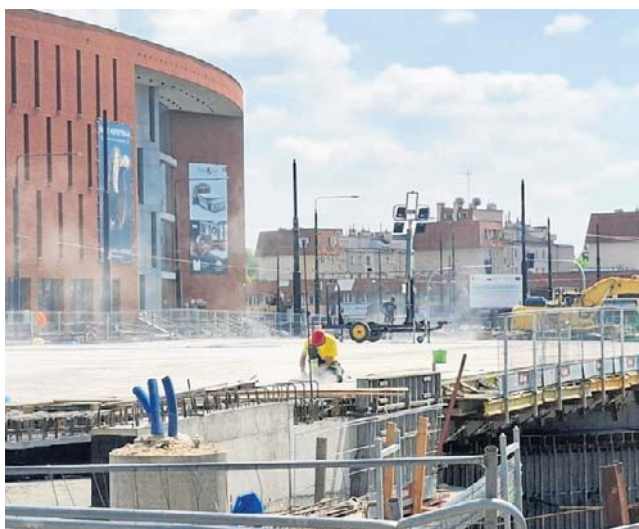
W tym tygodniu na płycie nowego mostu wylano beton. Kierowcy wjadą na niego najwcześniej w lipcu
