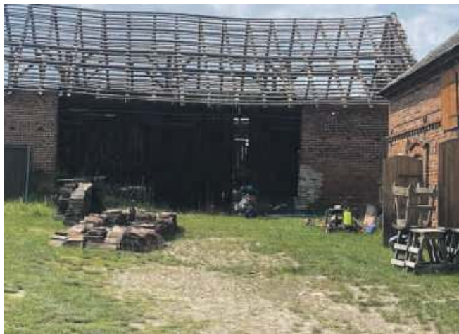
... oraz po rozbiórce
