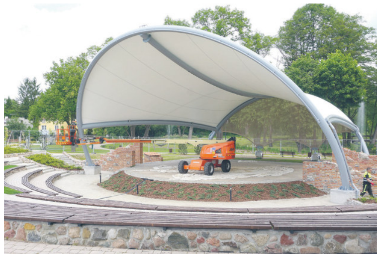
Ostatnie prace przy zadaszeniu nad sceną węgrowskiego amfiteatru
