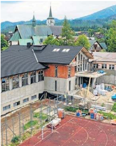
Przy szkole trwa budowa hali sportowej
