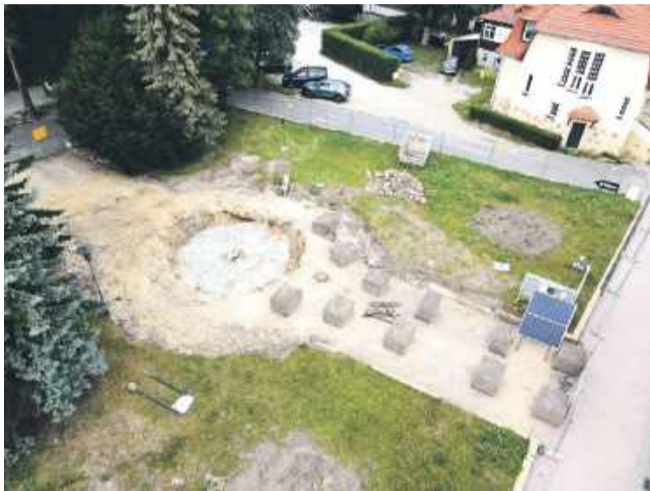
Zdjęcie wykonane zaraz po demontażu starej fontanny
