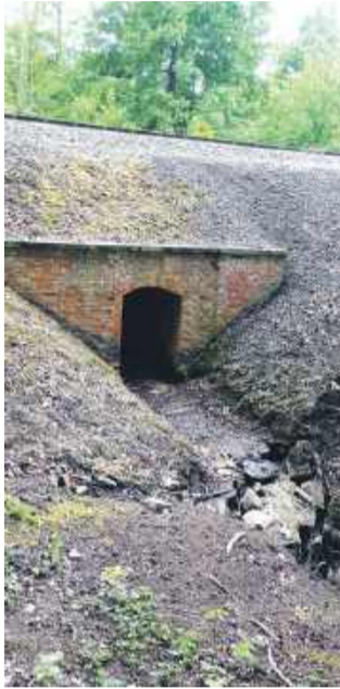
Nad przepustem biegnie linia kolejowa. Wejścia na torowisko zabraniają przepisy
