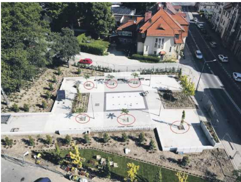
Na czerwono zaznaczyliśmy miejsca, gdzie betonowe płyty zostały usunięte
