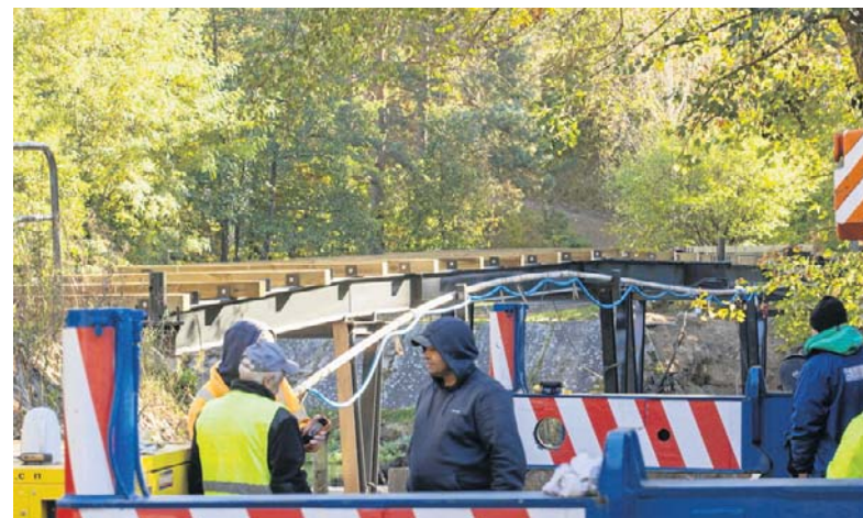
Trwa montaż konstrukcji. Wszystkie roboty mają zakończyć się pod koniec listopada
