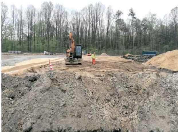
Trwające prace związane są z budową systemu drenażowego płyty boiska oraz odwodnienia liniowego i kanalizacji deszczowej
