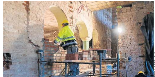
Prace wewnątrz pałacu w Nawrze
