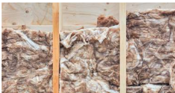
Izolacja ściany odpadową wełną owczą
