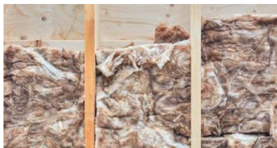
Izolacja ściany odpadową wełną owczą
