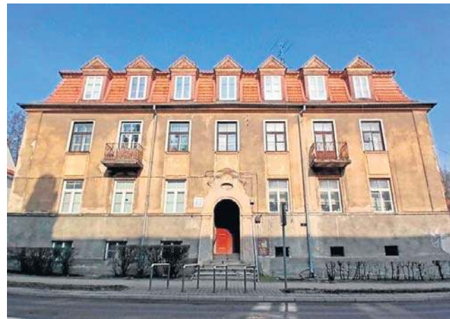
Przy Świętojańskiej 22 ma zostać przeprowadzony remont i przebudowa dachu kamienicy z 1924 roku
