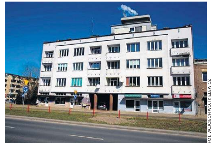
Wsparcie zostało przyznane też m.in. na prace remontowe w budynku z lat 1937-1939 przy ul. Branickiego 1
