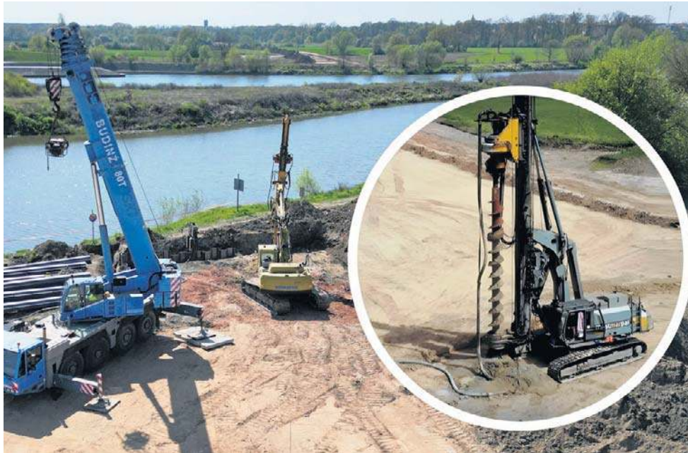
Potężna palownica drąży już otwory o głębokości 6 metrów.
