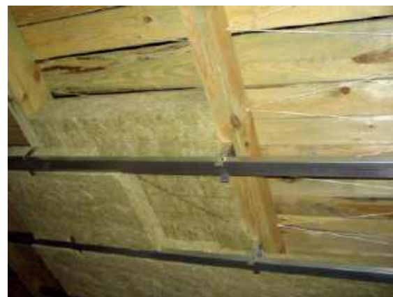
Szczelina wentylacyjna między ociepleniem z wełny i pełnym deskowaniem jest niezbędna. Żeby ją utworzyć, wykorzystujemy sznurek lub żyłkę. ROCKWOOL
