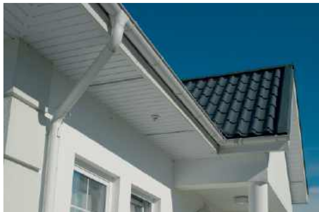
📌 Rynny i rury spustowe w kolorze dobranym do koloru elewacji i podbitki dachowej stają się praktycznie niewidoczne. RUUKKI
