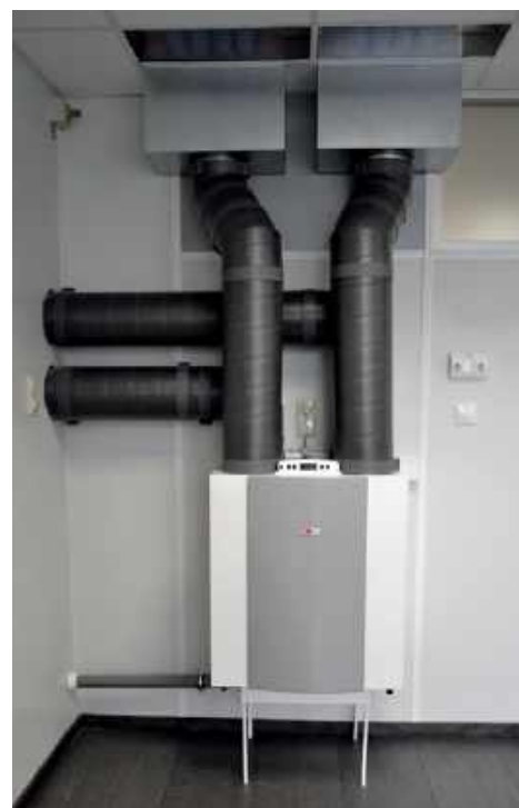
🔍 Izolacja kanałów chroni przed stratami ciepła i kondensacją wilgoci. Jest też elementem wygłuszającym. WOLF TECHNIKA GRZEWICZA
