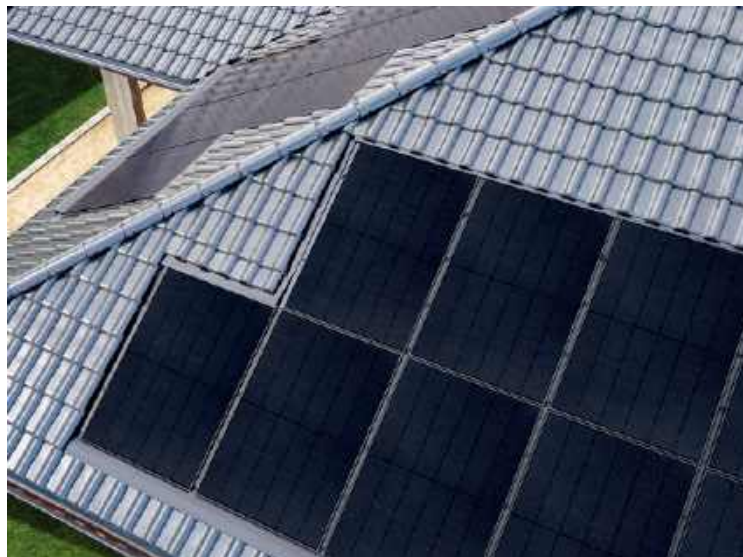
☞ W dachu solarnym panele zastępują część pokrycia. CREATON POLSKA, LINDAB
