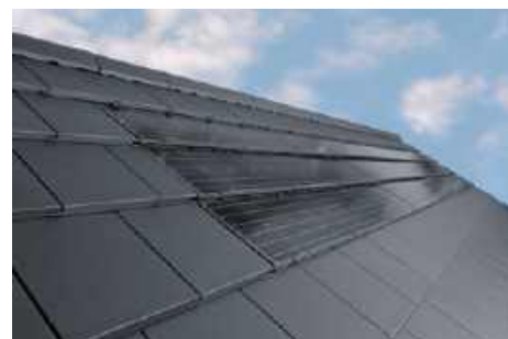
🔧 Zamontowanie dachówek solarnych pozwala uzyskać estetyczny dach o jednolitej formie. WIENERBERGER, BMI BRAAS FOTOWOLTAIKA
