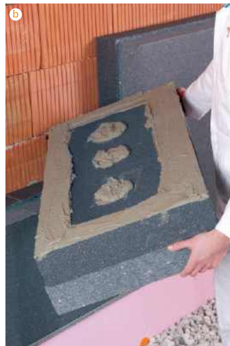
🔸 Zaprawę klejową nanosi się najpierw na cały obwód płyt termoizolacyjnych (a STYROPIMIN), a potem punktowo na ich powierzchnię (b AUSTROTHERM).
