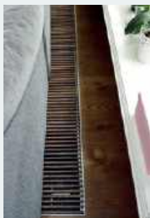
❷ Grzejnik kanałowy skutecznie chroni wnętrze przed chłodem.
