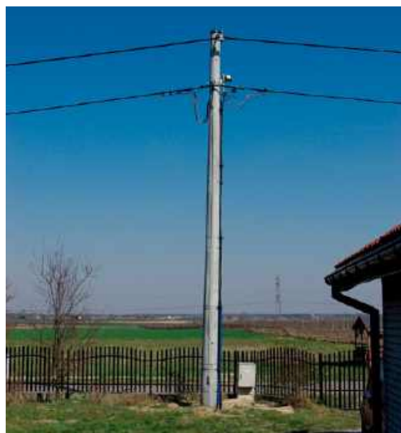
❶ Przyłącze kablowe (ziemne) to obecnie najchętniej wykonywany wariant, nawet gdy linia jest napowietrzna. J. ANTKIEWICZ
