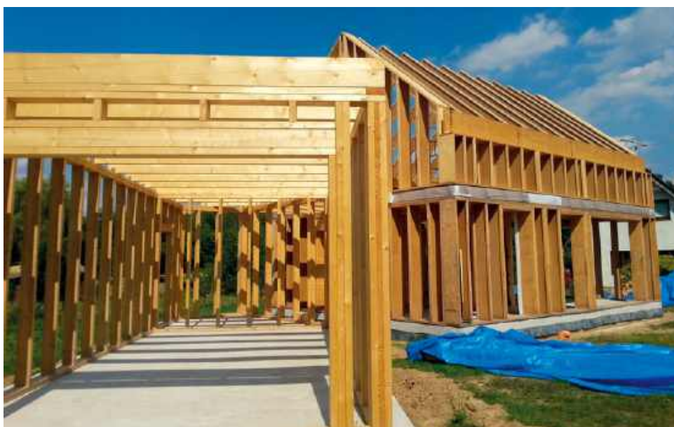
🔸 Ściany wznoszone metodą szkieletową szybko się buduje, jednak brakuje fachowców specjalizujących się w tej technologii. JAF POLSKA
