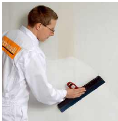
🔧 Masy szpachlowe służą do wyrównywania nierówności i pęknięć tynku. FERMACELL
