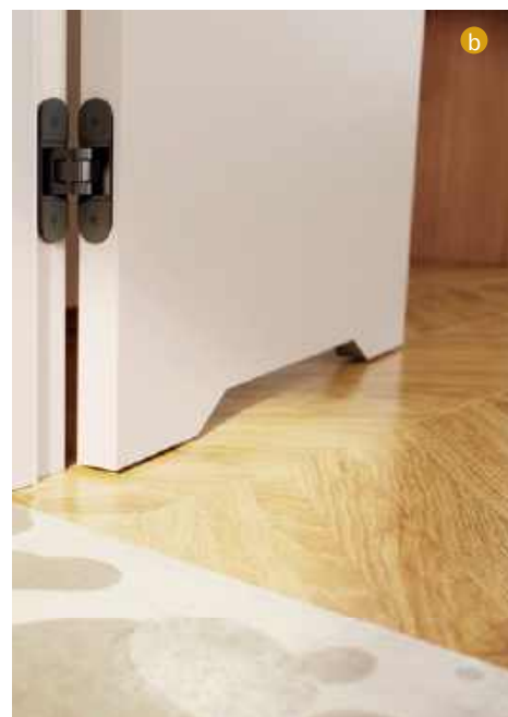
🔑 Drzwi do łazienki spójne z jej projektem (a). Muszą mieć podcięcie, albo otwory wentylacyjne (b). PORTA
