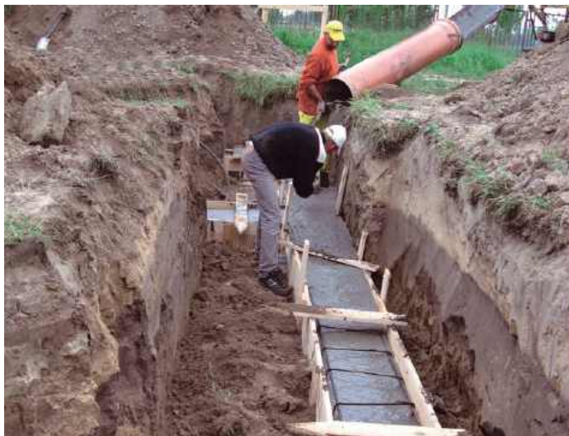
🔧 Uziom fundamentowy trzeba wykonać przed zalaniem zbrojenia ław. Niestety, na tak wczesnym etapie budowy wiele osób o tym nie pamięta. M. SZYMANIK
