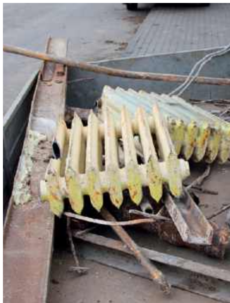
🔗 Odpady metalowe wyselekcjonowane z rozbiórki. J. WERNER
