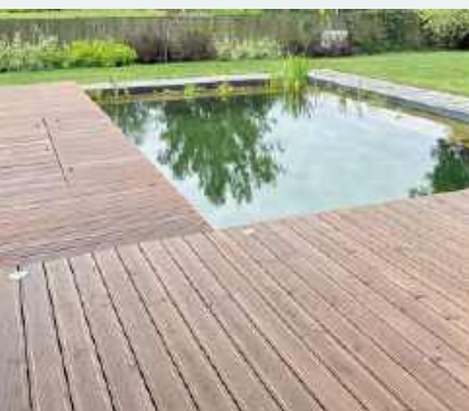
🔴 Ryflowane deski z modrzewia europejskiego przytwierdzono do legarów wkrętami do drewna.
