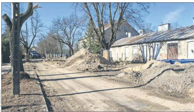
Trwa przebudowa pierwszego fragmentu ulicy Wyszogrodzkiej
