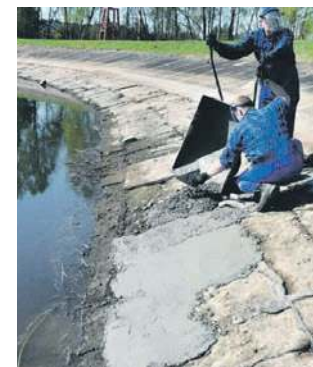
Ubiegłoroczne prace naprawcze przy jazie zapory
