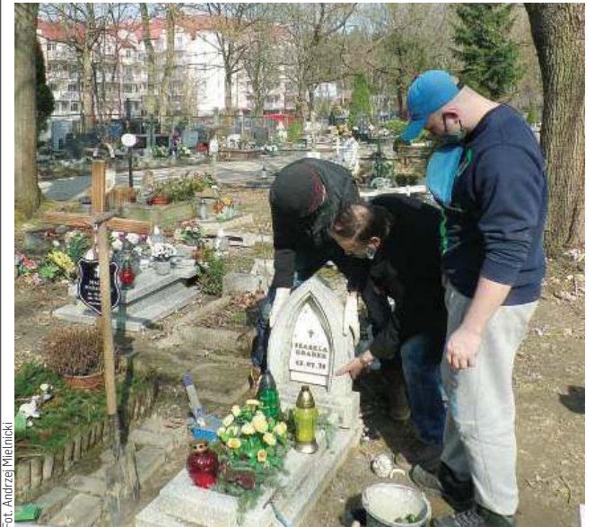
Kamieniarze naprawiają uszkodzone przez wandal nagrobki
