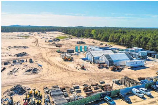
Na terenie budowy pierwszej elektrowni jądrowej w Choczewie prowadzone są ziemne prace
