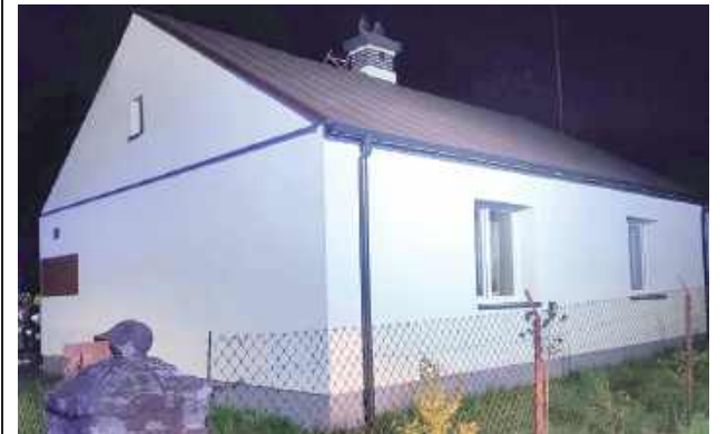
Pożar wybuchł w kuchni domu mieszkalnego
