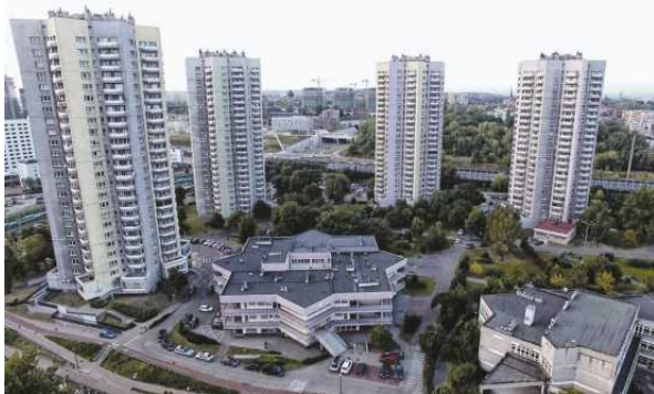
KSM buduje bezpieczne miasto od fundamentów
