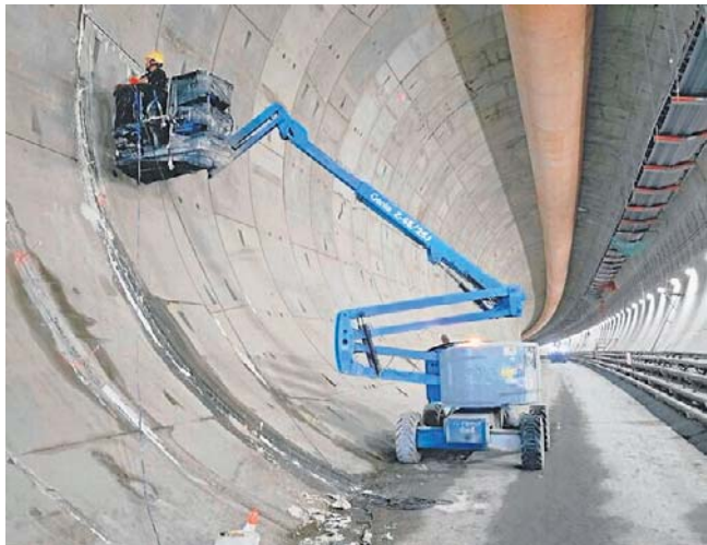
Drażnienie drugiej nawy tunelu rozpoczęło się na przełomie czerwca i lipca 2026 roku
