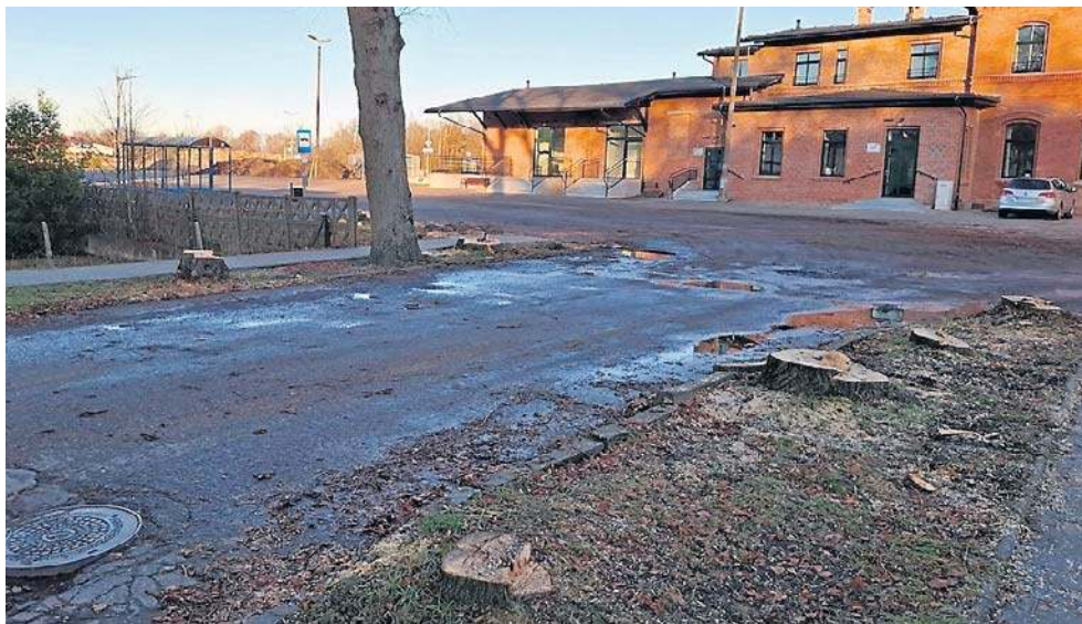
Dojazd do dworca PKP w Kępicach po wycince części drzew
