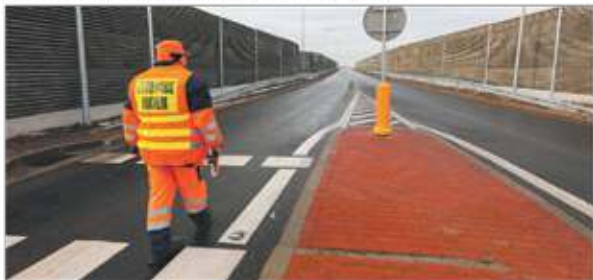
Na zdjęciu zakończenie drugiego etapu budowy obwodnicy Drezdenka.
