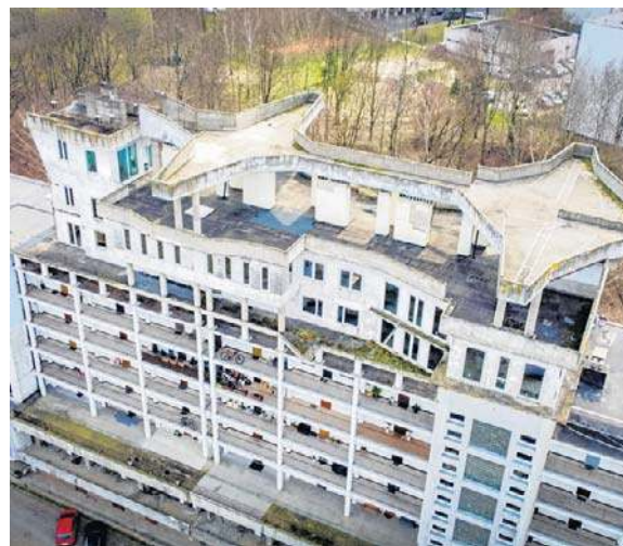
Część nadbudowy została już rozebrana
