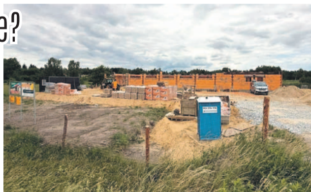
Z plakatu na płocie budowy wynika, że firma już szuka chętnych do pracy w tym markecie
