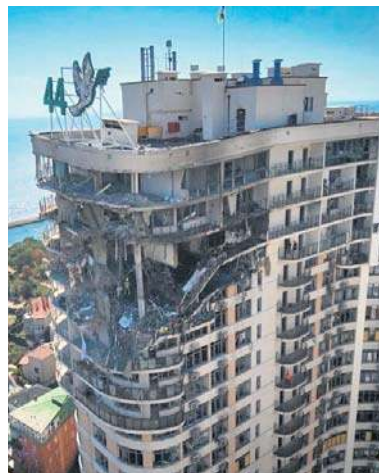
Rosjanie atakowali Odesę w nocy z soboty na niedzielę. Uszkodzono m.in. placówkę edukacyjną i wielopiętrowy budynek
