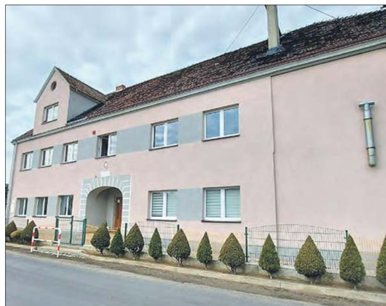
Obiekt Szkoły Podstawowej w Straduni
