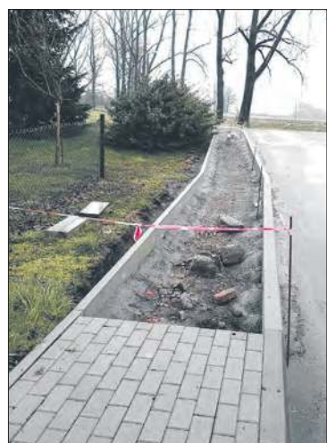
Budowa chodnika między Skrzypcem i Dytmarowem
