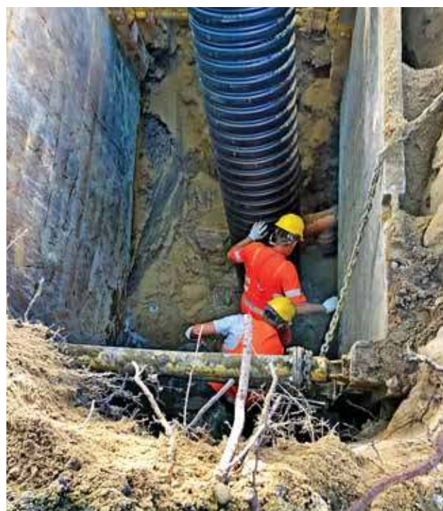
Budowa sieci kanalizacji sanitarnej
