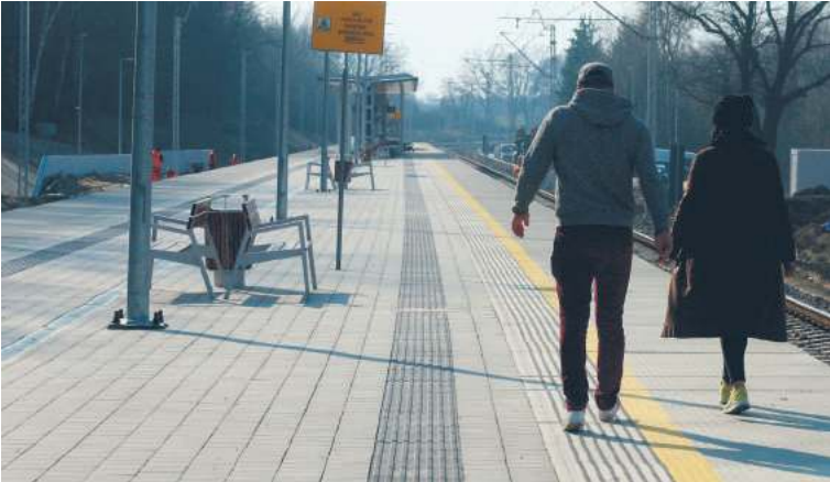
Chodnik prowadzący najkrótszą drogą z ulicy Szafirowej do przystanku PKP Lublin-Zachód powstanie jeszcze w tym roku
