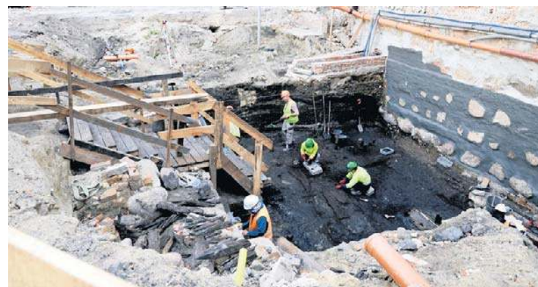
Prace przy modernizacji dziedzińców zajmą 2 lata
