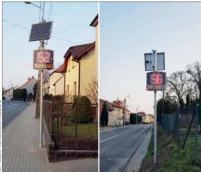
Radarowe wyświetlacze prędkości zamontowano przy ul. Starowiejskiej w Raciborzu
