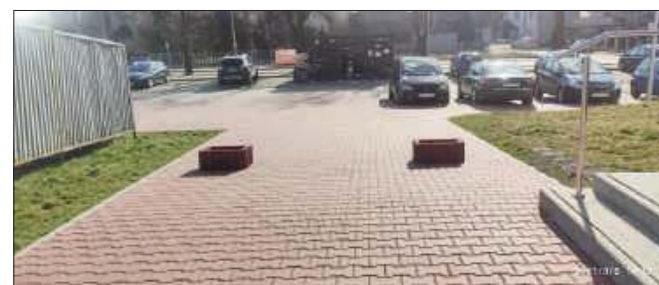
Kierowcy parkowali swoje samochody bezpośrednio przy klatkach schodowych pomimo tego, że w bezpośrednim sąsiedztwie budynku znajduje się parking
