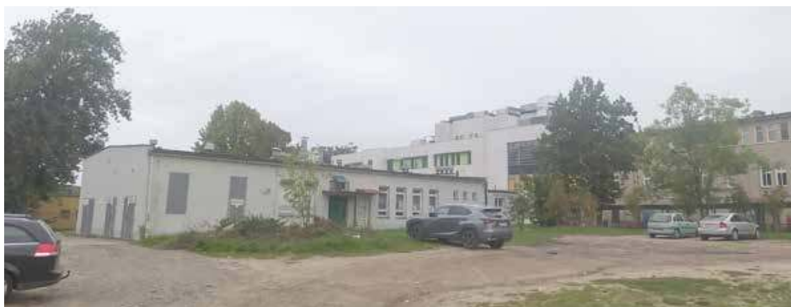
Widoczne po lewej stronie budynki fizykoterapii według najbardziej realnej koncepcji budowy lotniska miałyby być wyburzone. Tak samo wycięte powinny być rosnące w pobliżu drzewa
