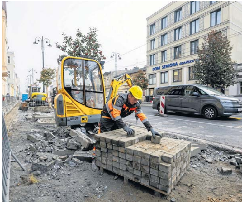
Na początek wybudowany zostanie przystanek w kierunku centrum miasta zlokalizowany na wysokości ul. Gdańskiej 125
