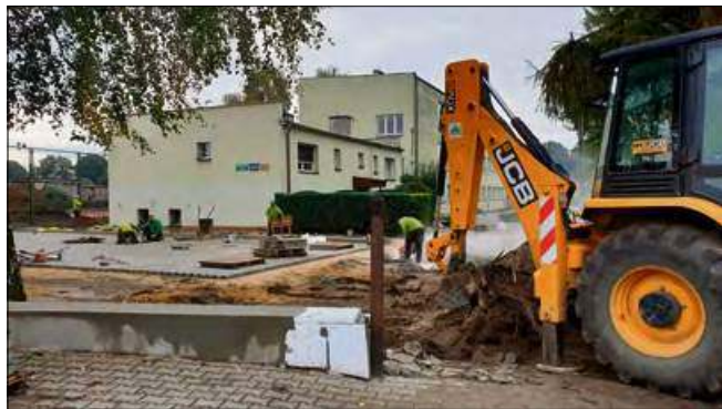
Roboty przy szkole trwają.
