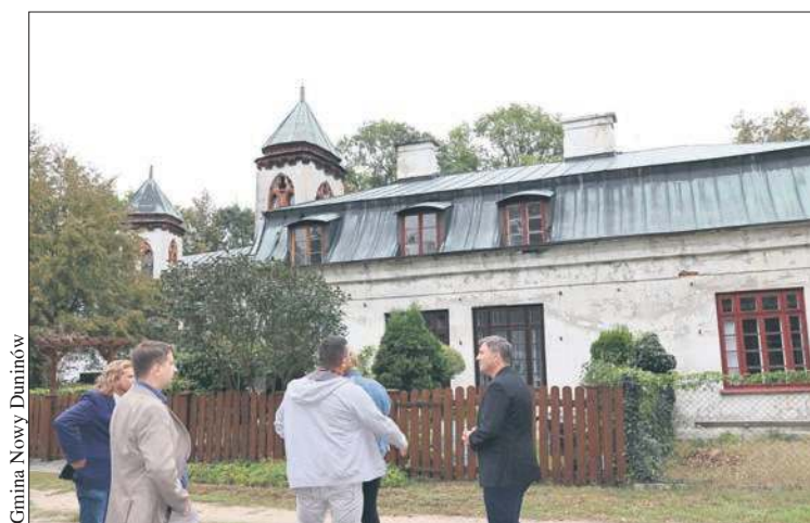
Prace konserwatorskie przy zabytkowym Pałacu Myśliwskim rozpoczną się wiosną przyszłego roku
