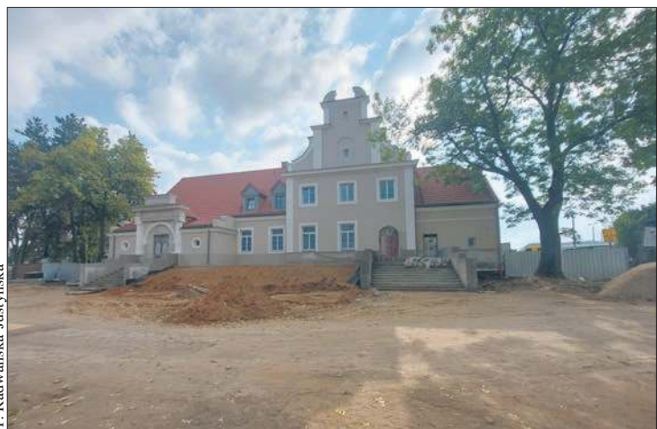
Na koniec bieżącego roku planowane jest zakończenie prac przy modernizacji dworca PKP w Sierpcu
