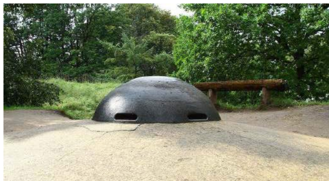
Fotografia 1. Kopuła pancerna jako obrazowa analogia ekranowania magnetycznego. Pochyły kształt czaszy zmienia kierunek biegu pocisków po ich uderzeniu w powierzchnię kopuły, co powoduje ślizganie się amunicji po panczeru. Analogicznie – ekran magnetyczny nie absorbuje pola magnetycznego, ale zmienia bieg jego linii w sposób, który chroni wnętrze ekranowanego urządzenia ( https://t.ly/6rTy )
