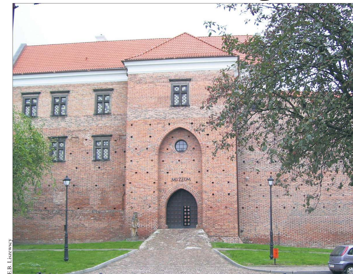
Zamek w Łęczycy. Widok na wieżę bramną
