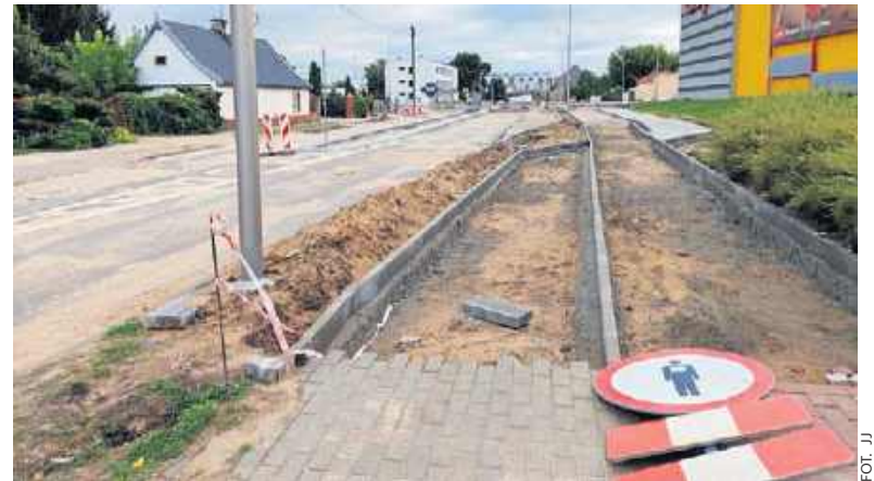
Inwestycja firmy Drogotom obejmuje nie tylko samo rondo, ale i uporządkowanie terenu przy skrzyżowaniu ul. Kapitulnej, Wysokiej i Długiej
