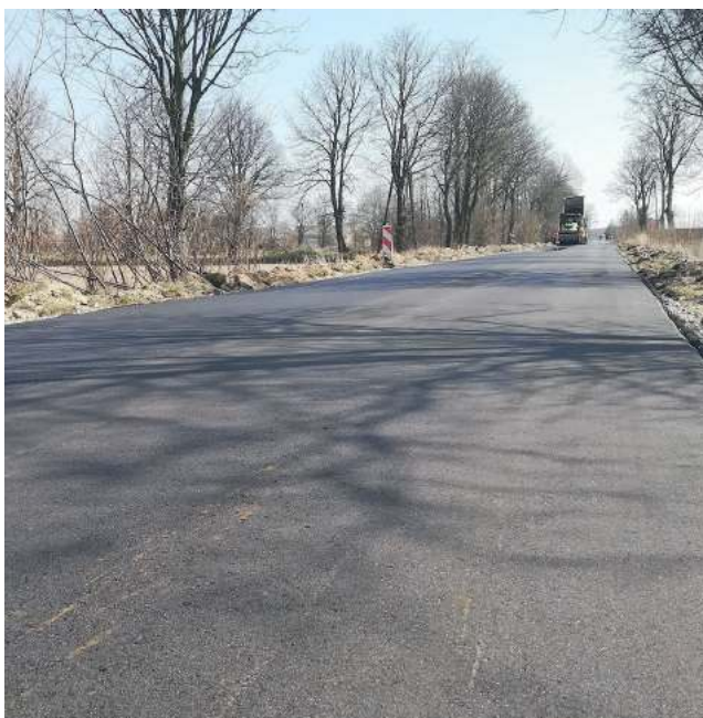
Parczewskie PRDM remontuje 433 metry drogi
