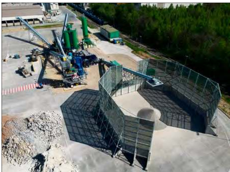
Przetwarzanych ma być do 100 ton odpadów betonowych na godzinę.
