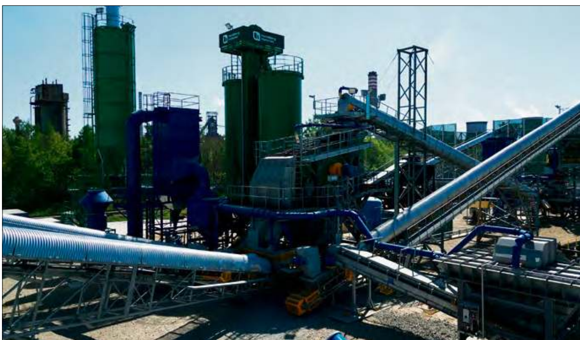
Do 2030 roku 50 proc. produktów betonowych Heidelberg Materials ma zawierać produkty z recyklingu.
