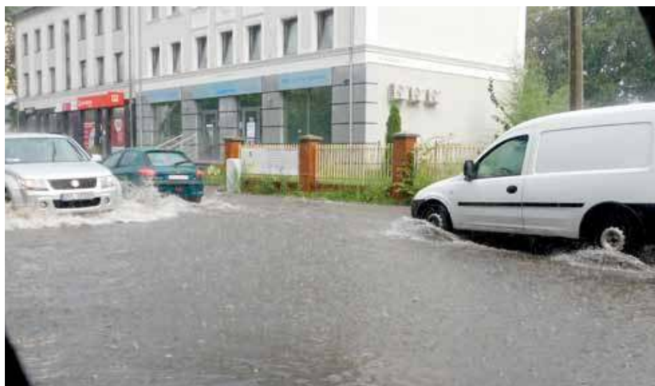
Na ul. Bankowej zatyka się studzienka w jezdni obok byłej gazowni
