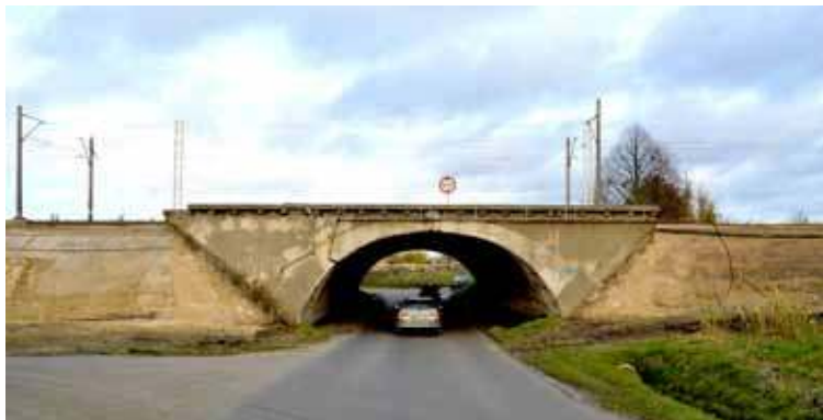
Od 4 grudnia na kilka tygodni zostanie otwarty wiadukt na ulicy Składowej
