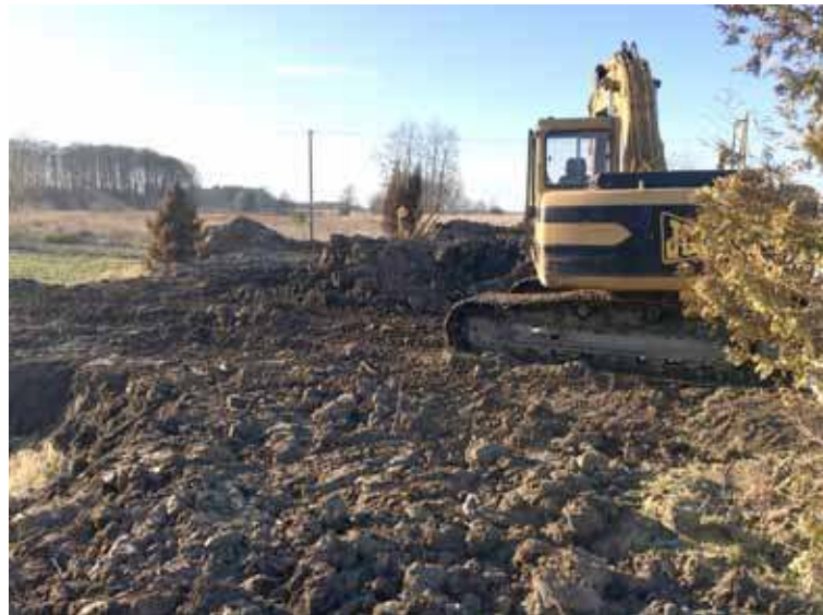
Prawidłowo wykonane prace ziemne są podstawą założenia dobrze funkcjonującego ogrodu
