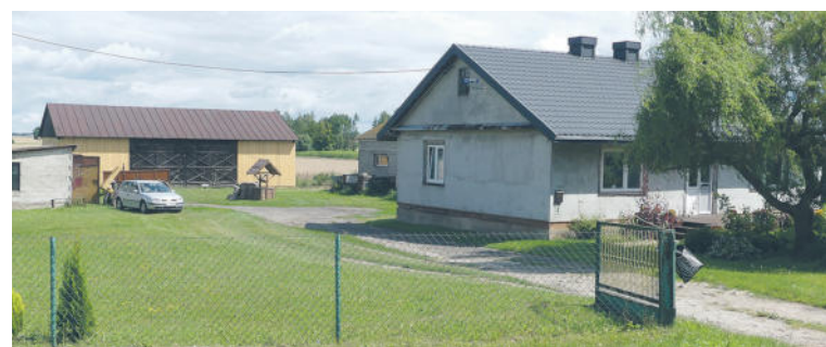
Między innymi te budynki mogą zostać wyburzone. fot. arch.
