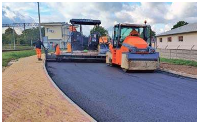
Na ul. Ogrodowej w Bytomiu Odrzańskim wylano już asfaltowy dywan
