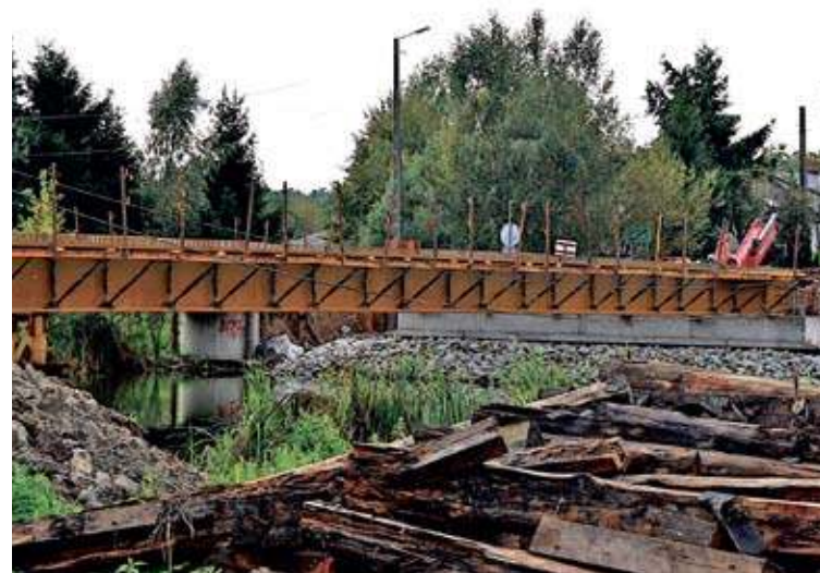
Trwa kolejny etap budowy nowego mostu w Tatarkach (fot. powiat nowosolski)
