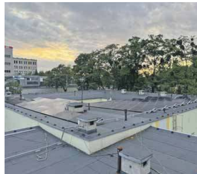
Zakończono instalację paneli fotowoltaicznych
