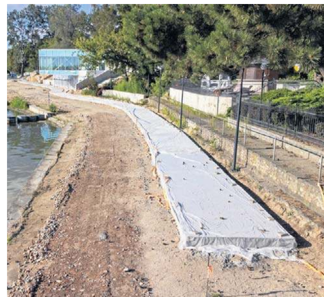
Powstają kolejne elementy placu zabaw, trybuna przy przyszłym boisku do siatkówki plażowej, schody i ścieżka wzdłuż plaży.
