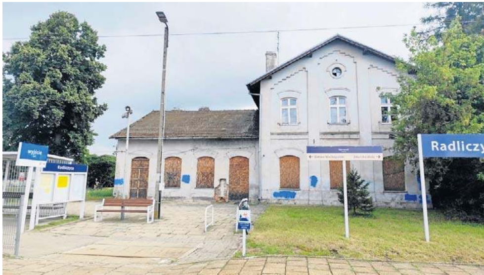
Dworzec Kolejowy w Radliczycach czeka na remont. Gmina przygotowała dokumentację.
