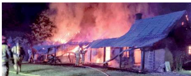
Pożar budynków gospodarczych. Dach zawalił się do środka
